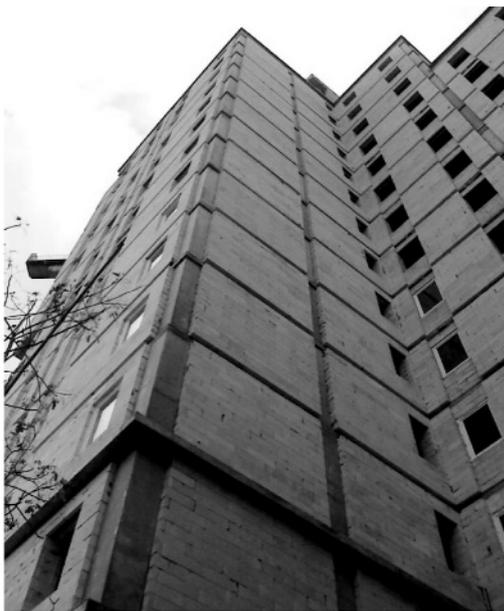
**Рис. 1.** Монолитно-каркасное здание с самонесущими внешними стенами из ячеистобетонных блоков автоклавного твердения
